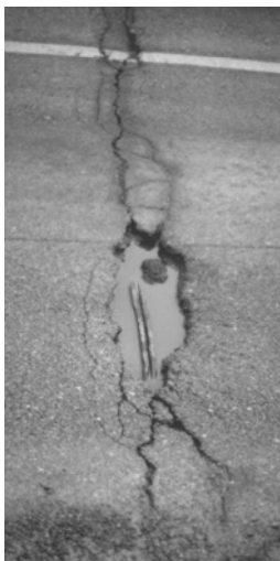
primjer dotrajalosti prijelazne naprave uslijed prometnog opterećenja
