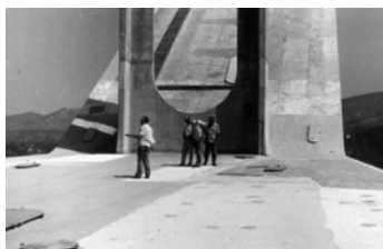
zaštita betona luka Krčkog mosta od korozije
