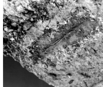
primjeri djelovanja mora nošenog burom na beton Paškog mosta
