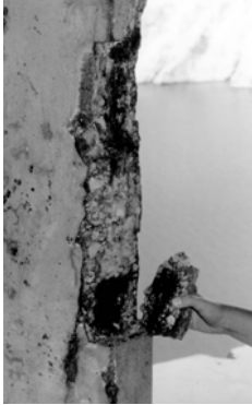
primjeri djelovanja mora nošenog burom na beton Paškog mosta
